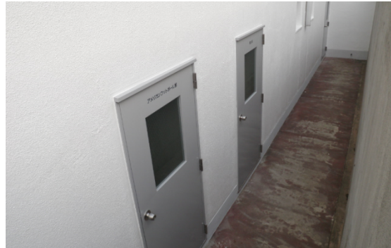
新しくなった入口（工事後）
