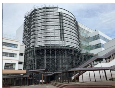
(改修工事の様子)
