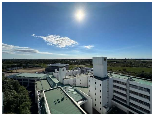
<屋上防水改修>
