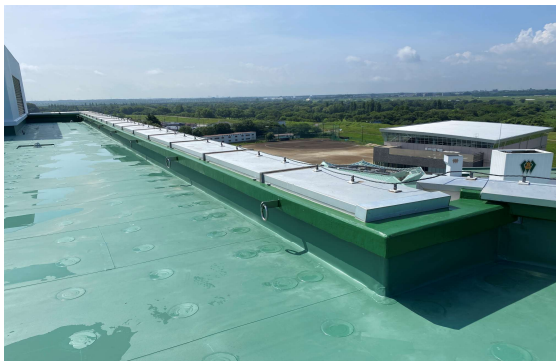
<屋上防水改修>
