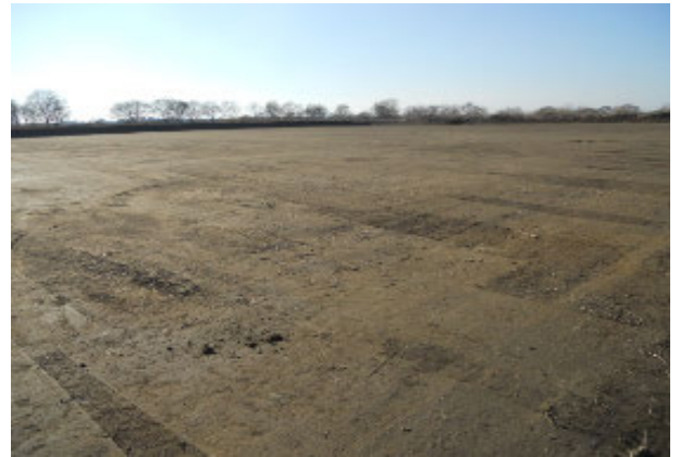
重機により整地された整備後
